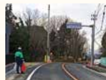
工事が進む 県道17号府中造田線
